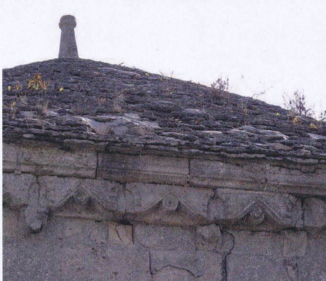
Détails de la couverture en lauze hors d'usage : forte présence de végétation, nombreux éléments cassés, solins en mortier des rives latérales en mauvais état
