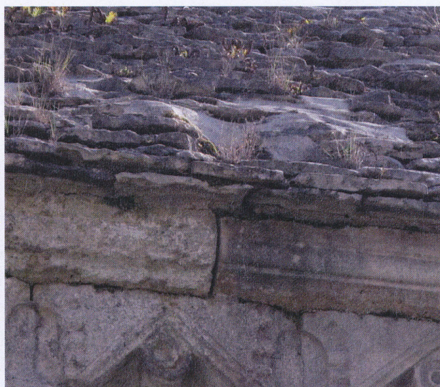
Détails de la couverture en lauze hors d'usage : forte présence de végétation, nombreux éléments cassés, solins en mortier des rives latérales en mauvais état
